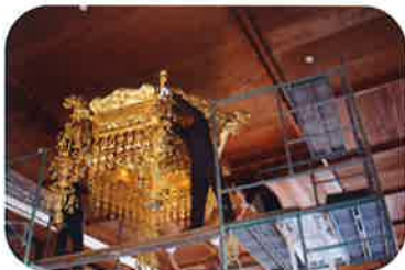
天蓋修復の様子
